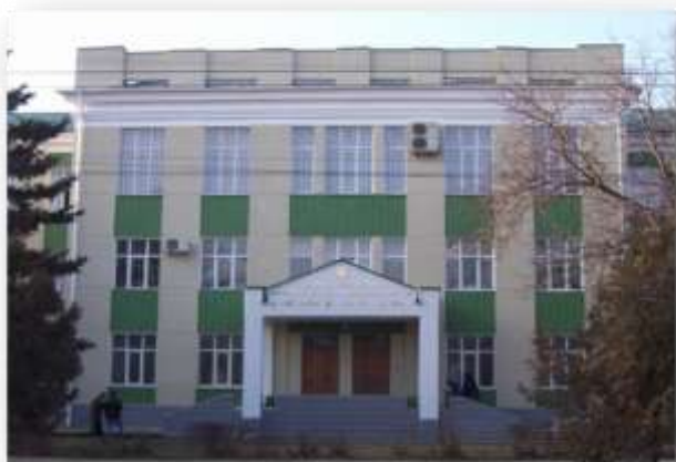
Сімферополь. Будівля Головного управління Державного казначейства України в АРК по вул. Севастопольській, 19
